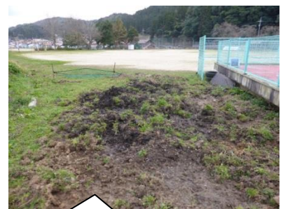
プール横の地面の様子(前方がグラウンド)
