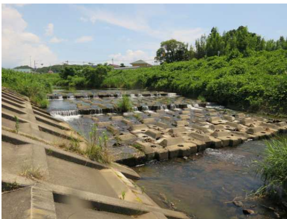
図 2-10 枯木橋下流の床止（魚道なし）
