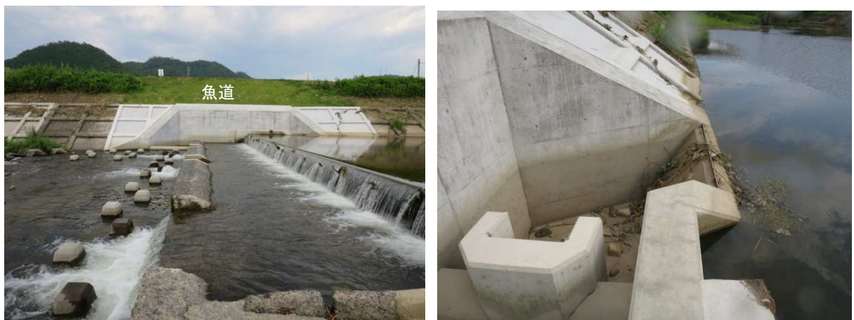
図 2-8 吉永地先の頭首工と魚道（右）。魚道には通水されていない
