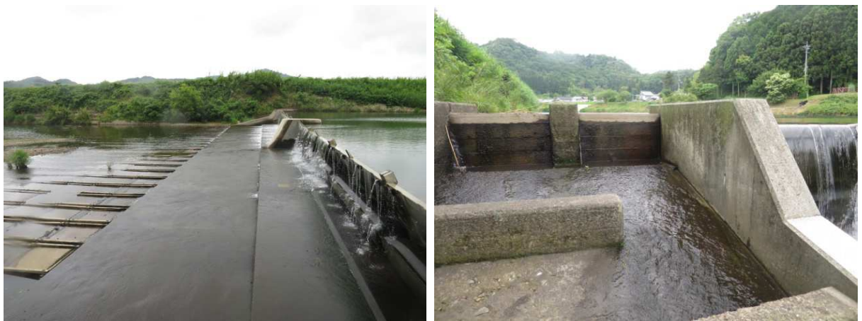
図 2-5 和田堰と右岸側に設けられた導流壁式魚道
